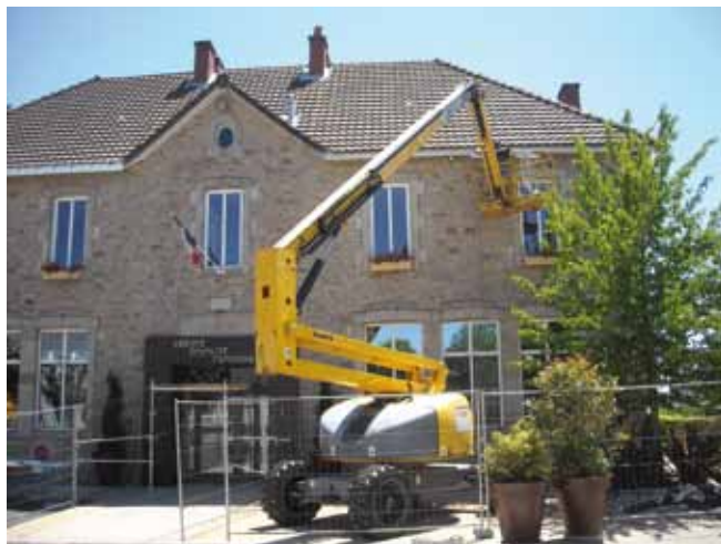
Reprise de sous-toiture de la Mairie
